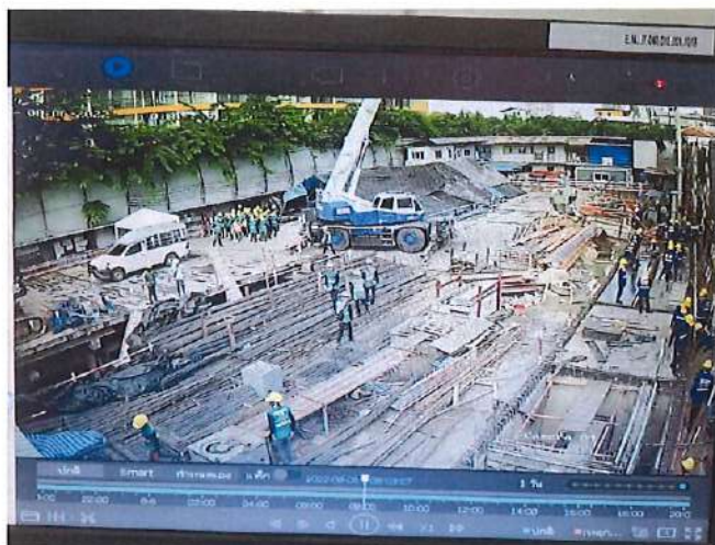
เวลา 08.03 น. งานผูกเหล็ก เข้าแบบฝาบ่อบำบัด
