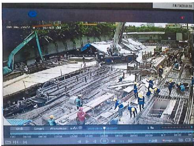
เวลา 16.03 น. งานผูกเหล็ก เข้าแบบฝาบ่อบำบัด
